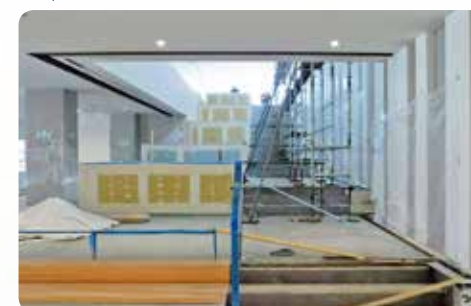
施工中大階段
